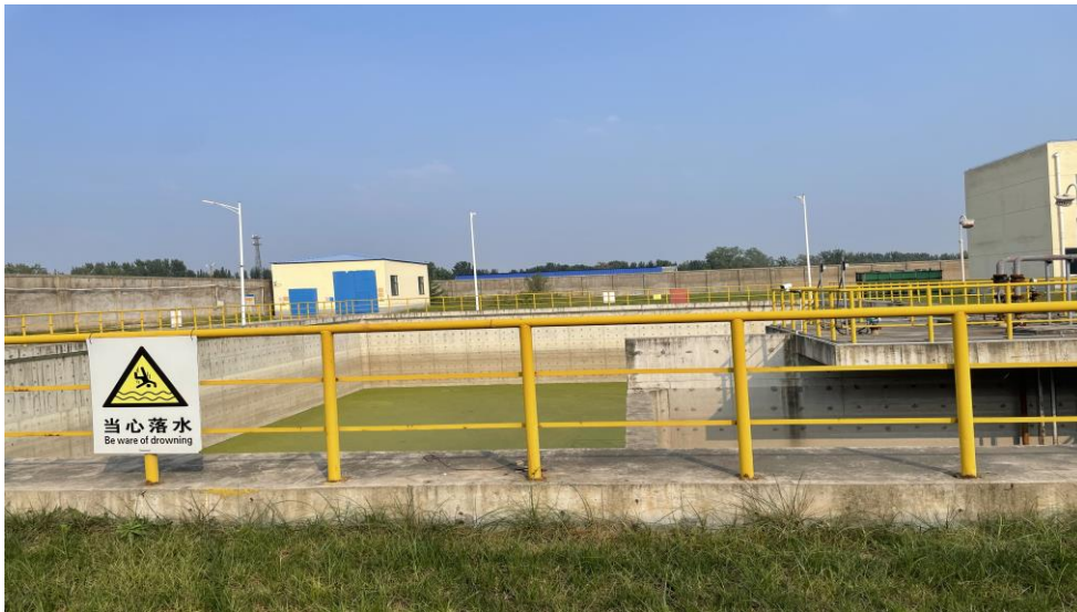
图 3.2-2 厂区事故废水池（兼初期雨水池）（图中水为收集的初期雨水）
