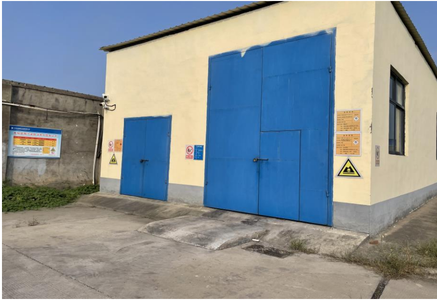
图 3.2-3 厂内现有危险废物暂存间
